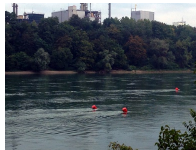
Vue de la station de surveillance de Bâle : des flotteurs pour mesurer le taux d'élévation du Rhin, en prévision d'éventuelles inondations.
